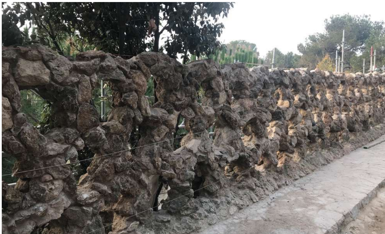
Restauració viaducte de baix
